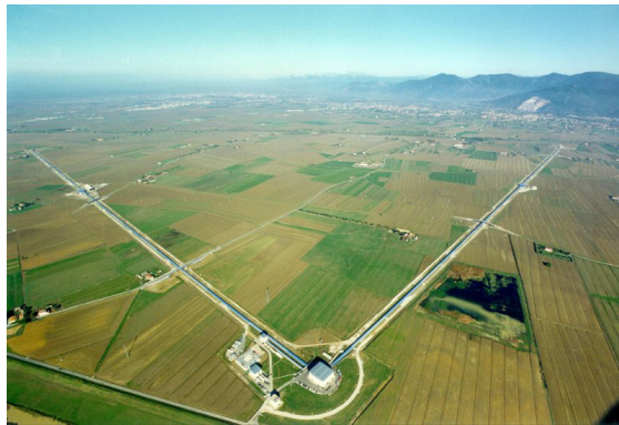
Obr. 2. Snímek evropského interferometru VIRGO délky 3 km u Pisy.
